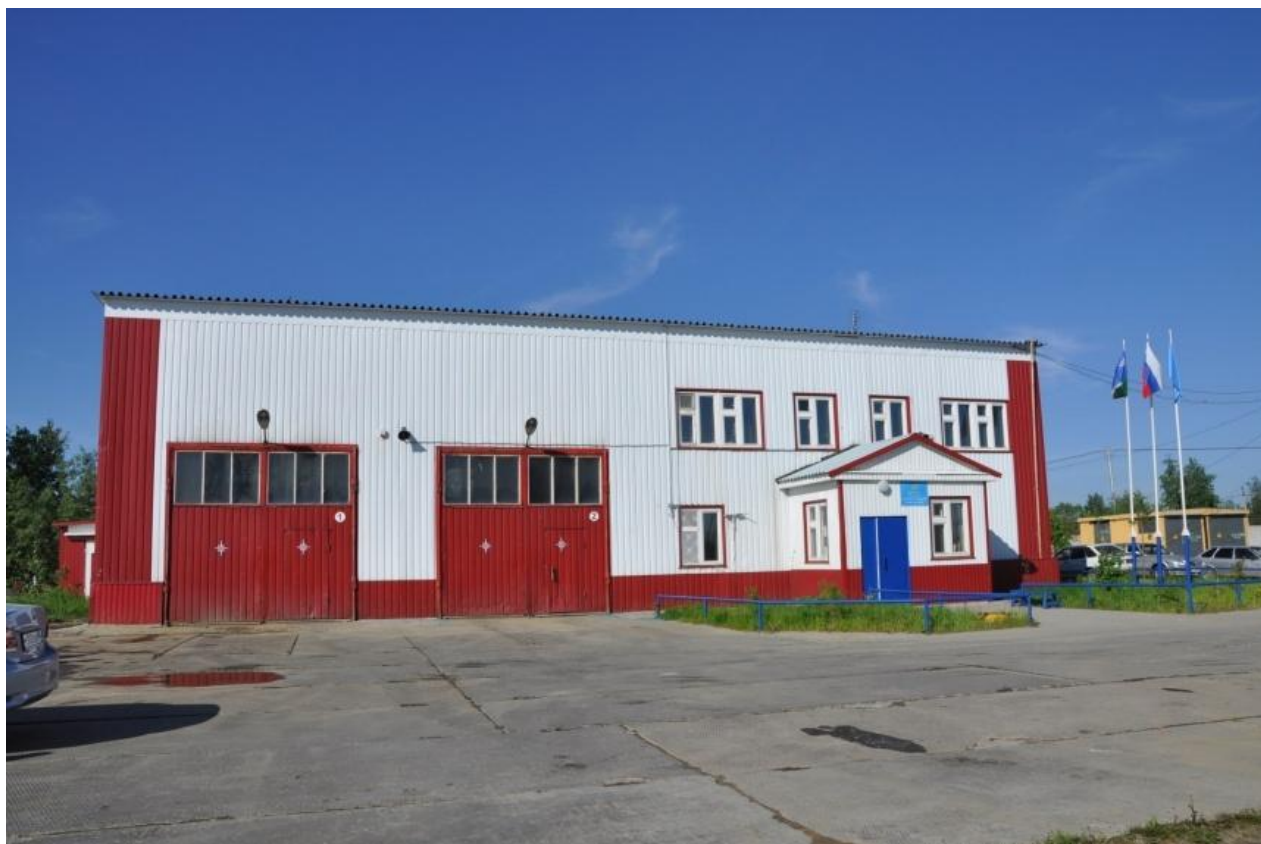
97-ая пожарно-спасательная часть г.Нижневартовск, 2 П-2 Западный промышленный узел, 85
