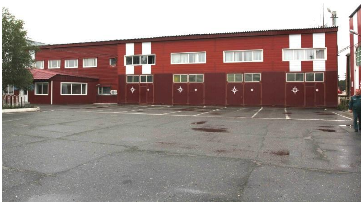
35-ая пожарно-спасательная часть, г.Лянтор, ул. Магистральная, 18 а
