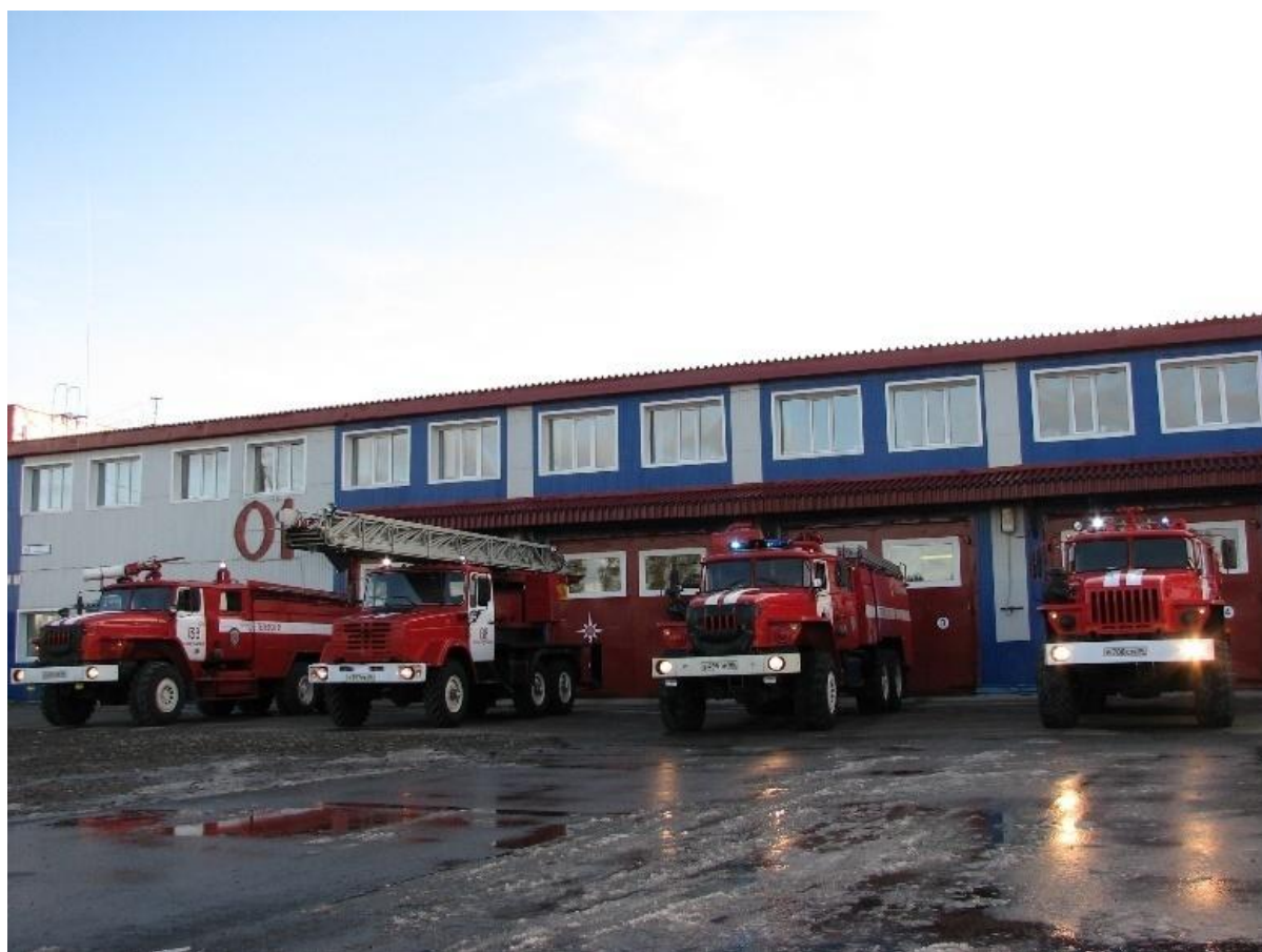
138-ая пожарно-спасательная часть, п.Нижнесортывмский, ул.Рабочая, 3
