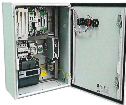
Рисунок А.11.3 – Блок запуска оповещения электромеханической сирены (ПГМ-БЗО-ЭС).
